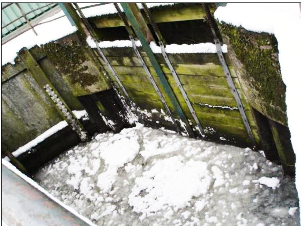
**Abbildung 6:** Wehranlage (zwei Holzwehre mit je 1,50 m Breite) im Bereich der alten Kleinbahnbrücke. (Foto: DHI [14])
