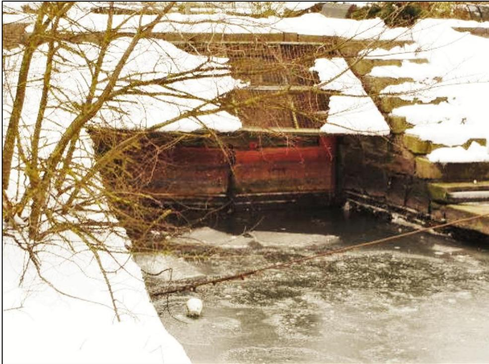
**Abbildung 5:** Rückschlagstore am Auslass des Noorkanals zum Eckernförder Binnenhafen. (Foto: DHI [14])
